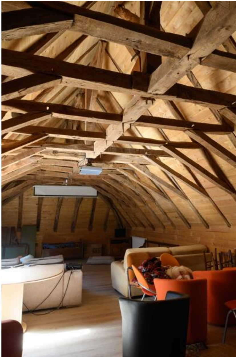
Détail de la charpente du corps de logis.
