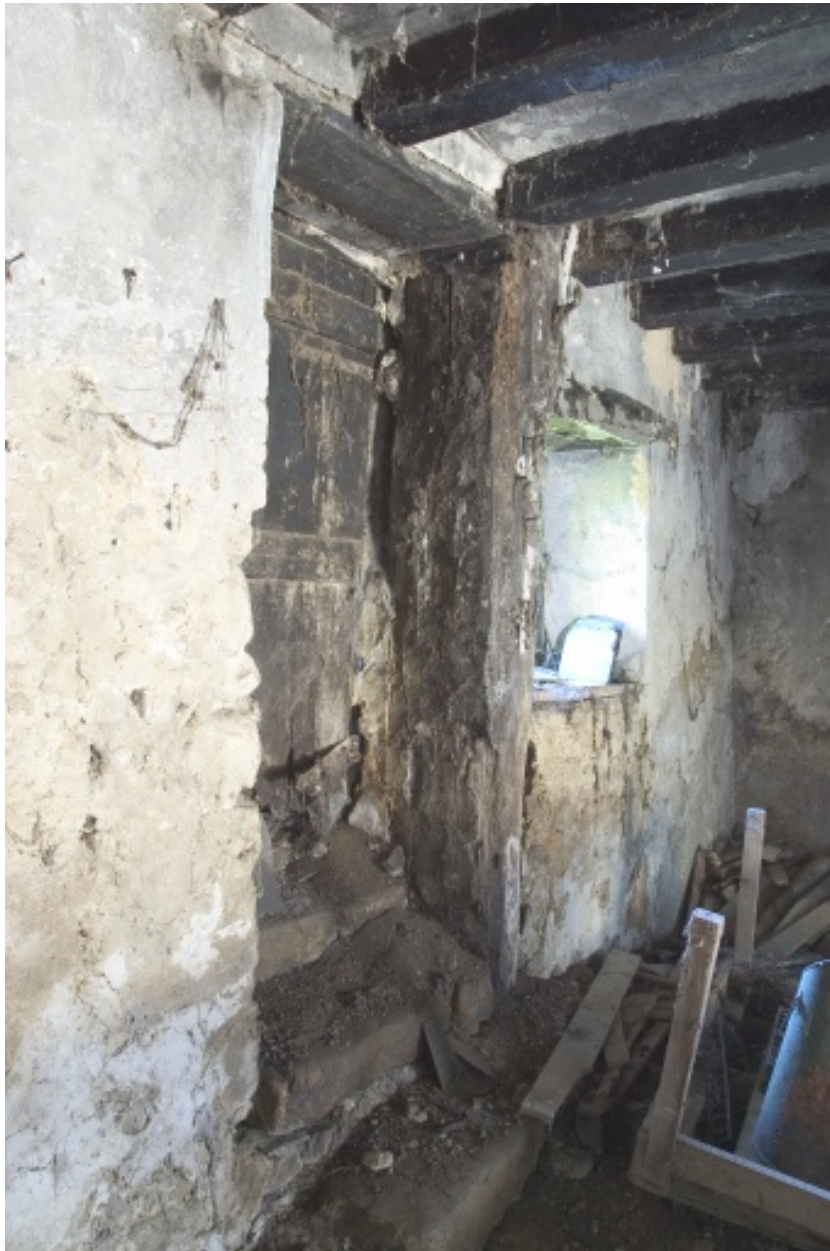
Vue intérieure de la pièce à cheminée située dans la partie ouest de l'ancien logis : la porte et la fenêtre percées dans le mur sud.
