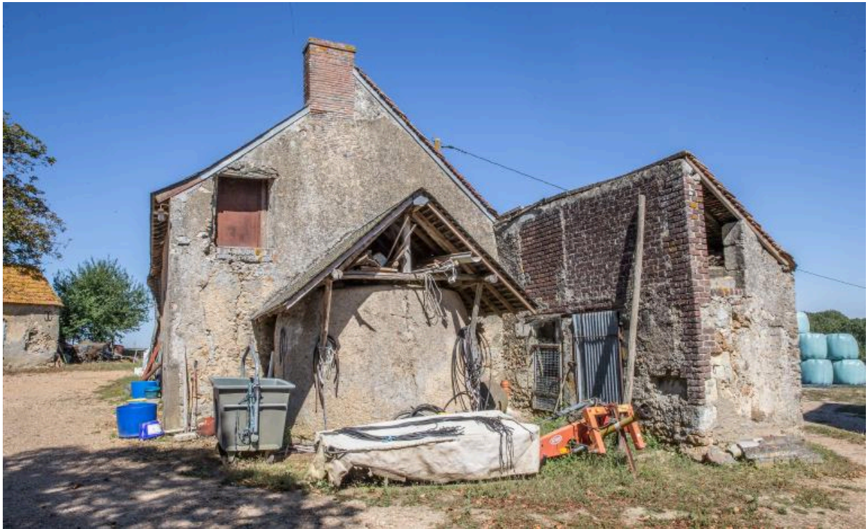
Four à pain au pignon du logis. Soue "bricolée" en briques et moellons de calcaire et silex.
