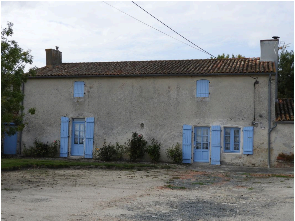
Le logis des Bardettes, construit à la fin du 18e siècle ou au début du 19e.
