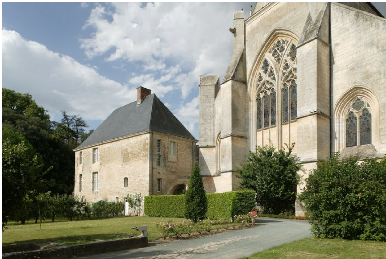
Bâtiment des archives : vue prise du nord-est.
