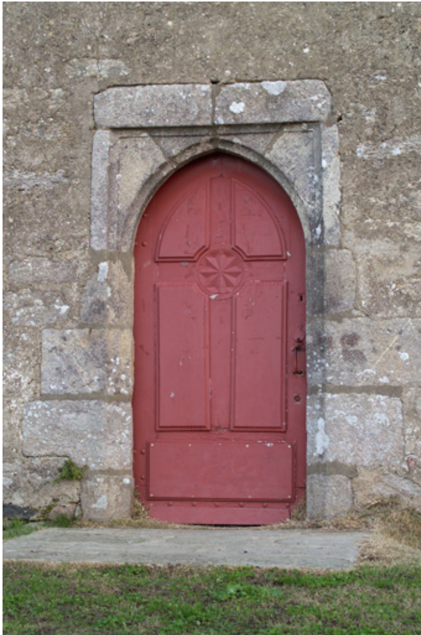
Porte dans le mur sud.
