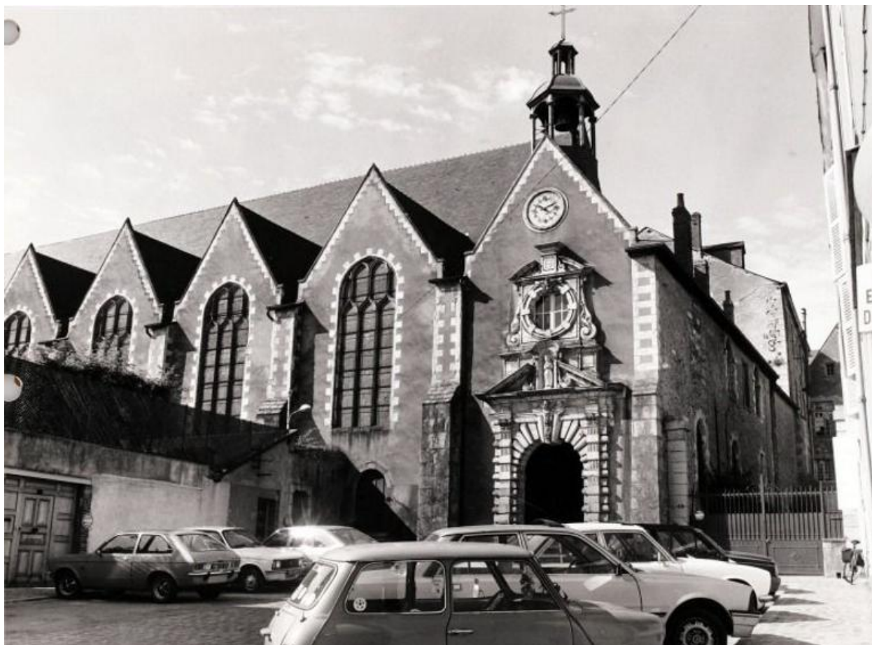
Eglise, élévation nord : vue d'ensemble.
