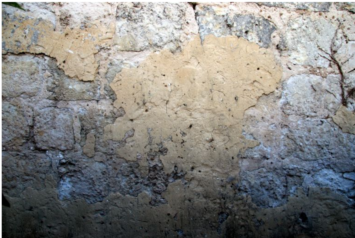
Mur de la nef : enduits.
