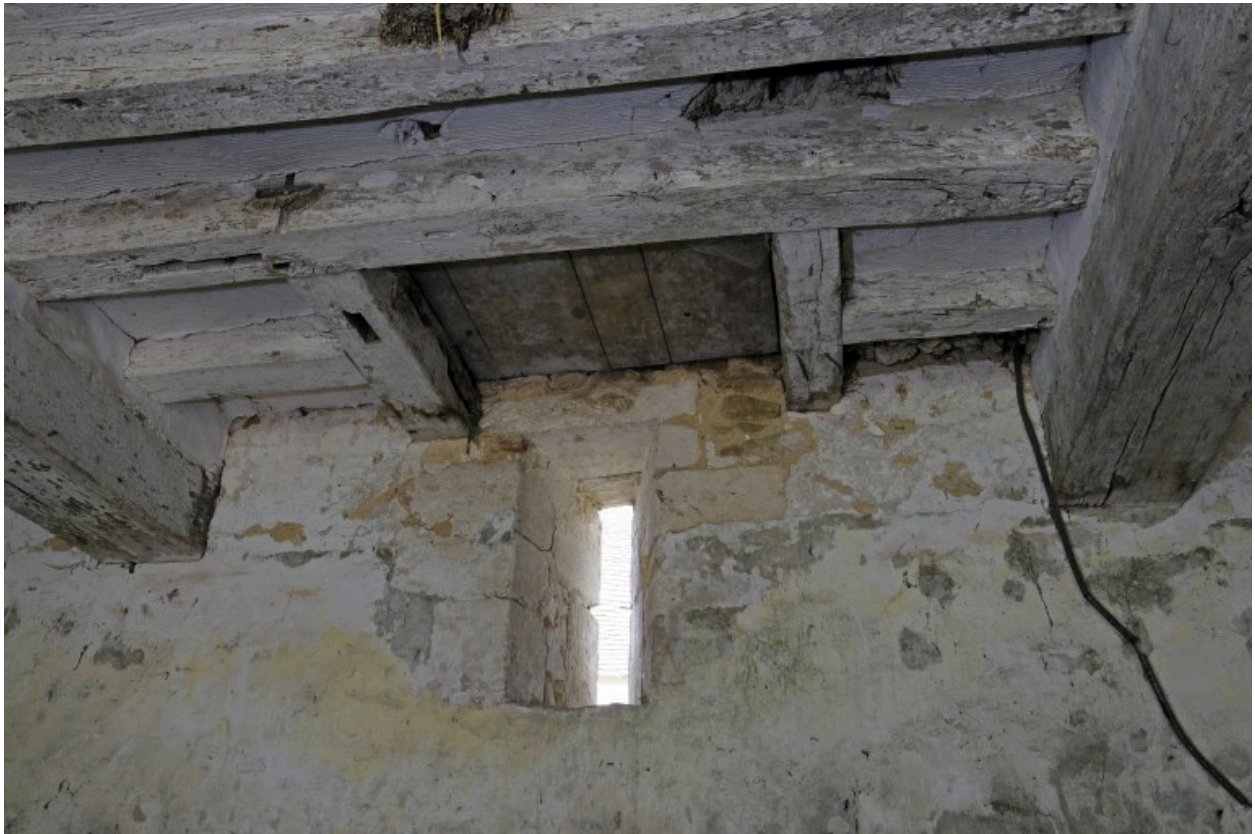
Fournil-remise, élévation postérieure : jour en archère ouvrant sur le cimetière.
