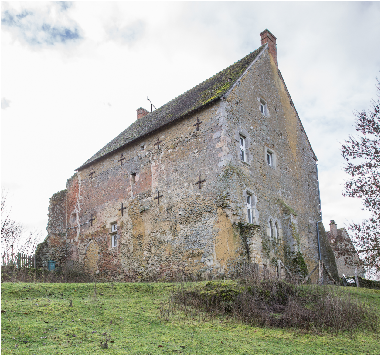
Une vue d'ensemble du manoir depuis le nord.
