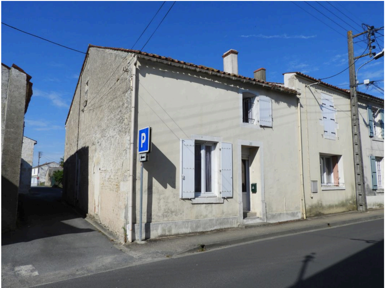
La maison, ancienne auberge, vue depuis le nord-est.
