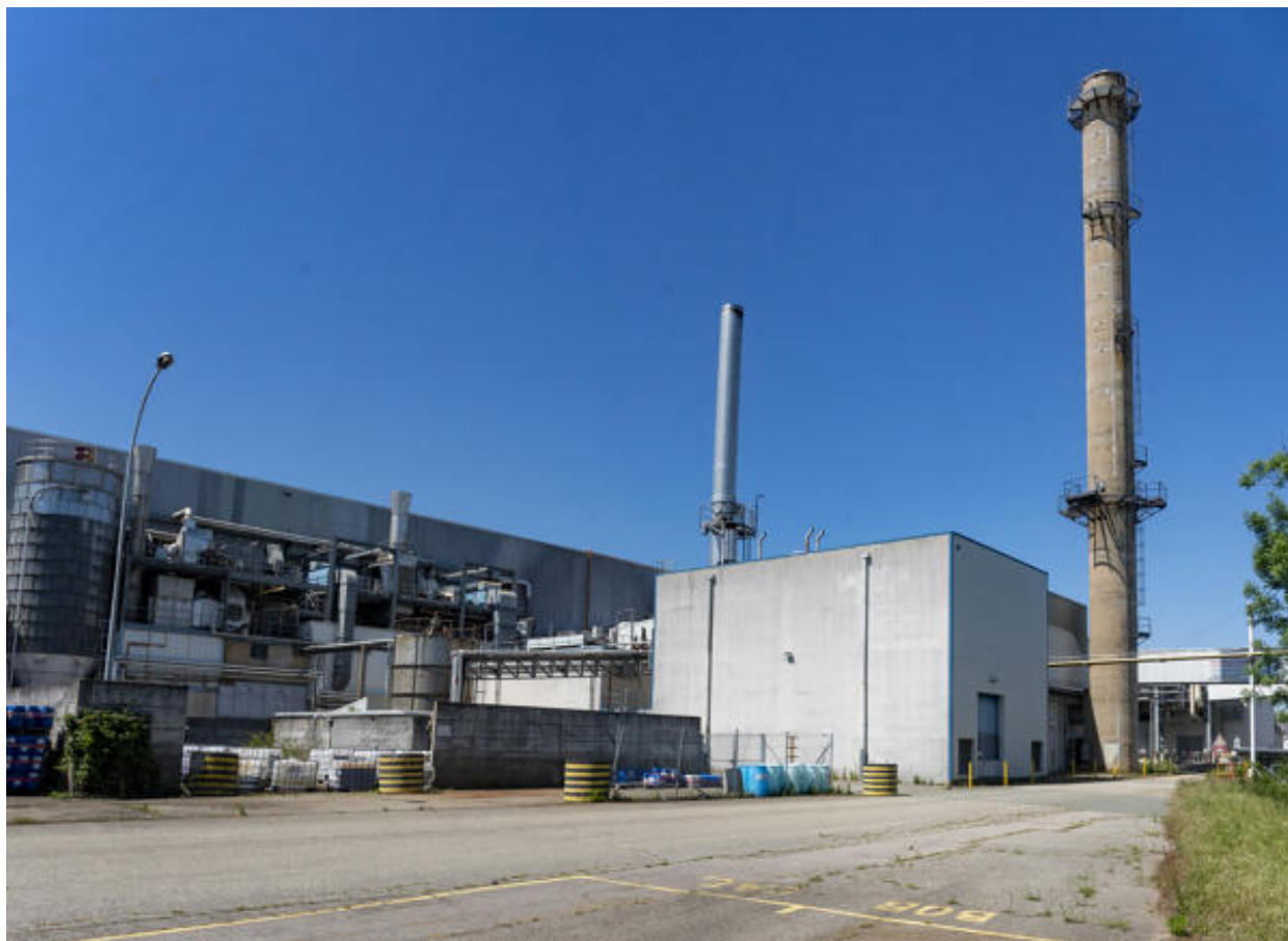
Vue du bâtiment de la troisième machine à papier (bâtiment M) depuis le sud.
