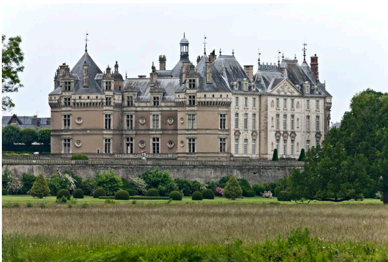
Le château : façades méridionale et orientale.
