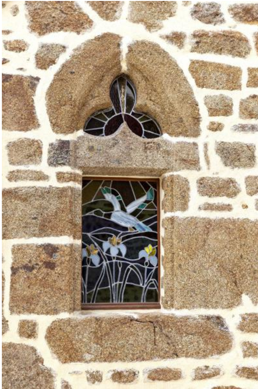
Baie trilobée du mur-pignon oriental.
