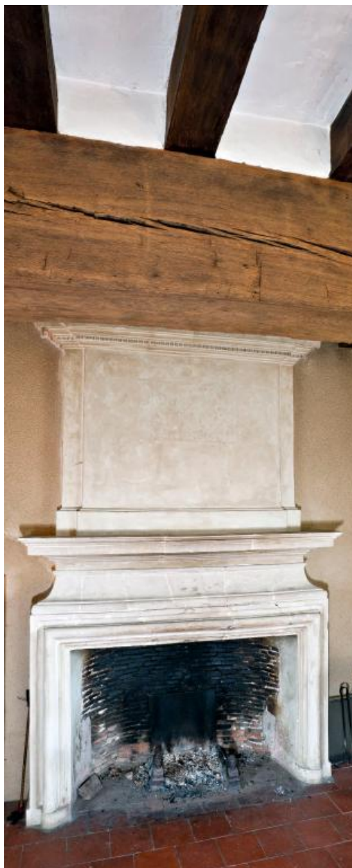
Logis central, chambre à feu côté nord : cheminée et grosse poutre.
