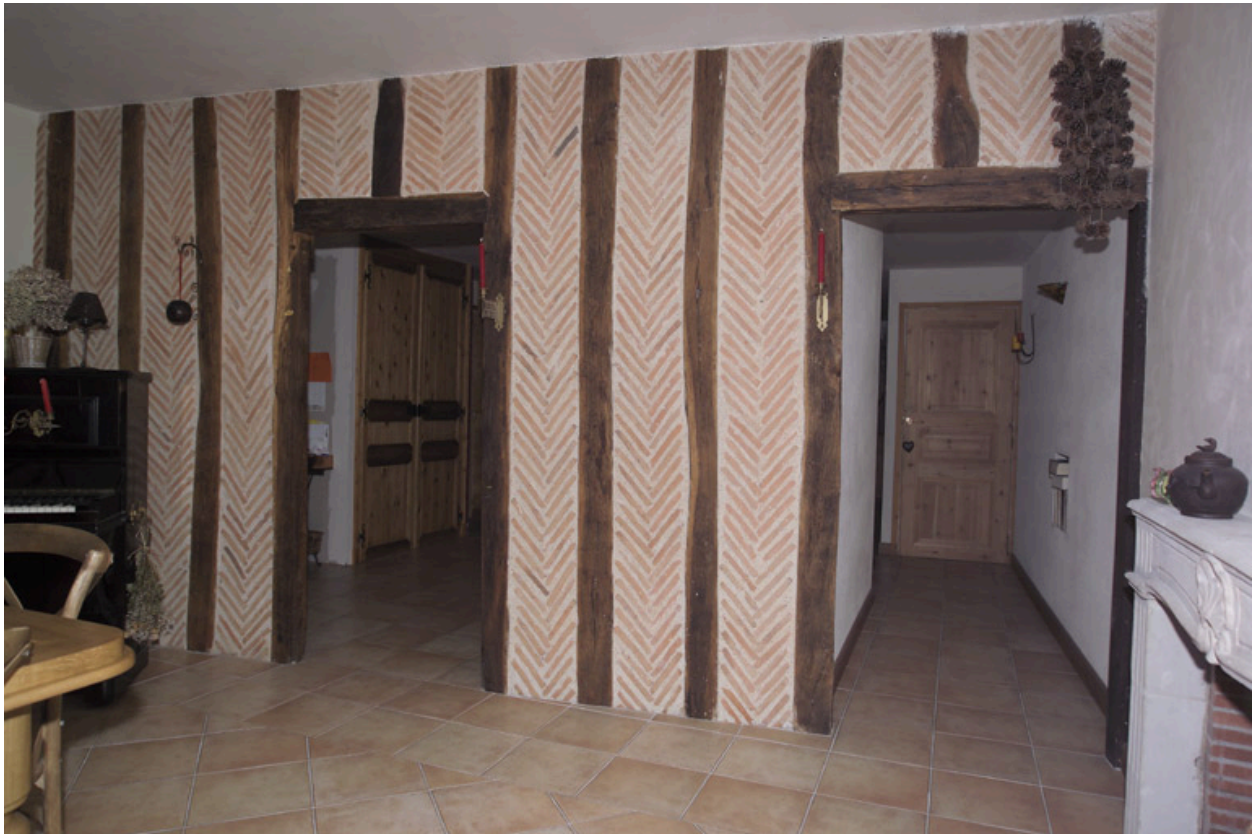
Le mur de refend isolant à l'origine l'escalier, vu depuis le corps secondaire vers le quai.
