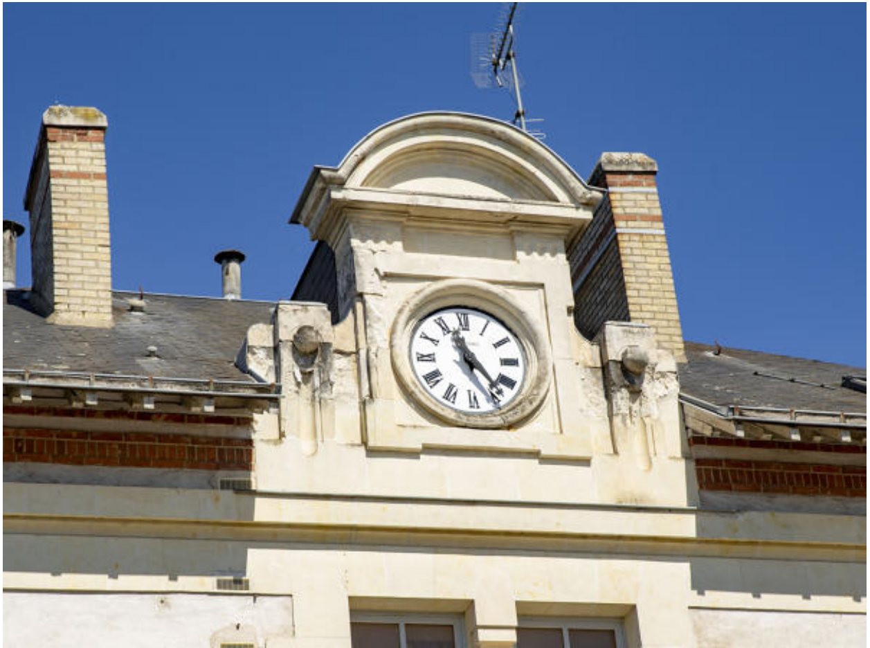
La lucarne et l'horloge du logement de l'école de filles.
