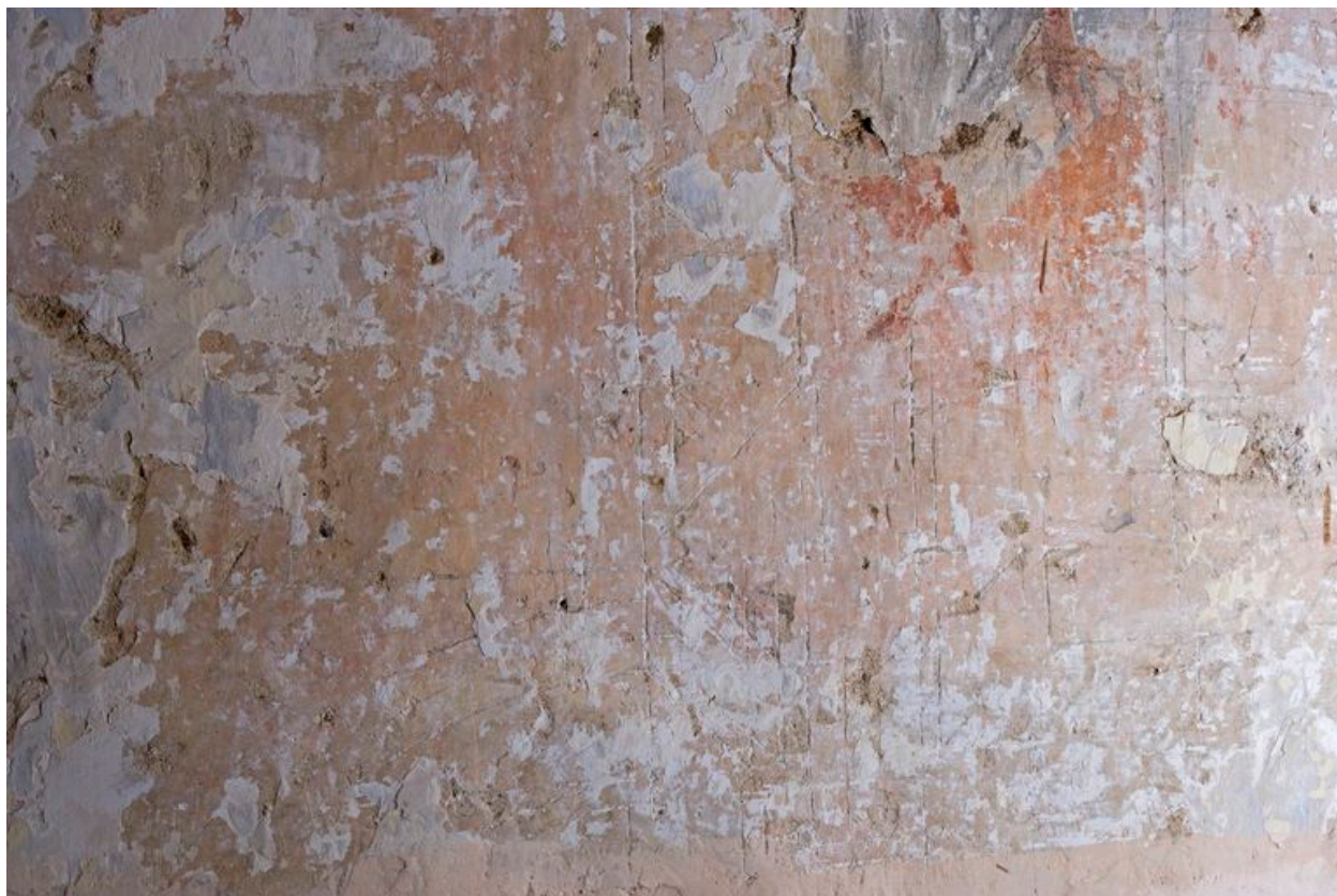
Nef, mur sud. Vue partielle de l'épure d'architecture, peut-être celle du clocher.
