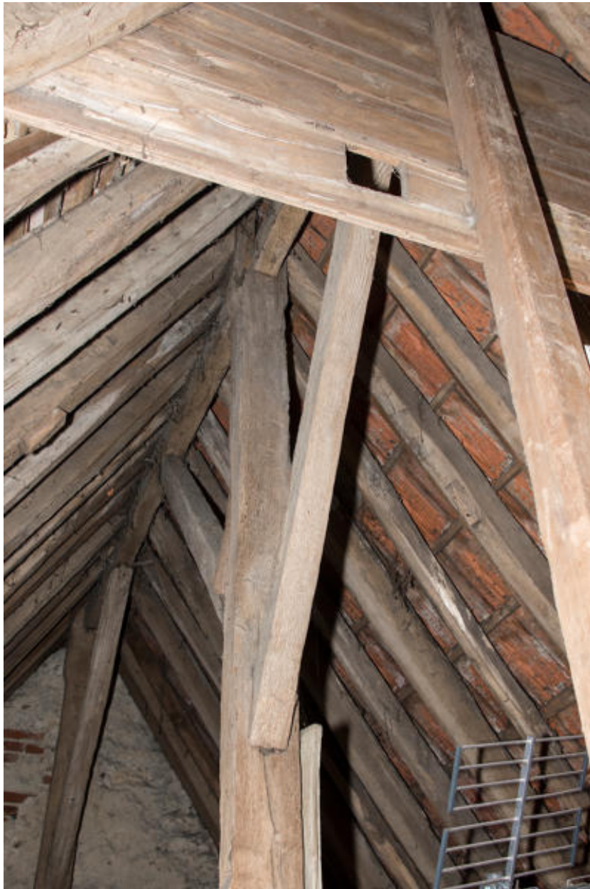
Vue de la ferme de charpente.
