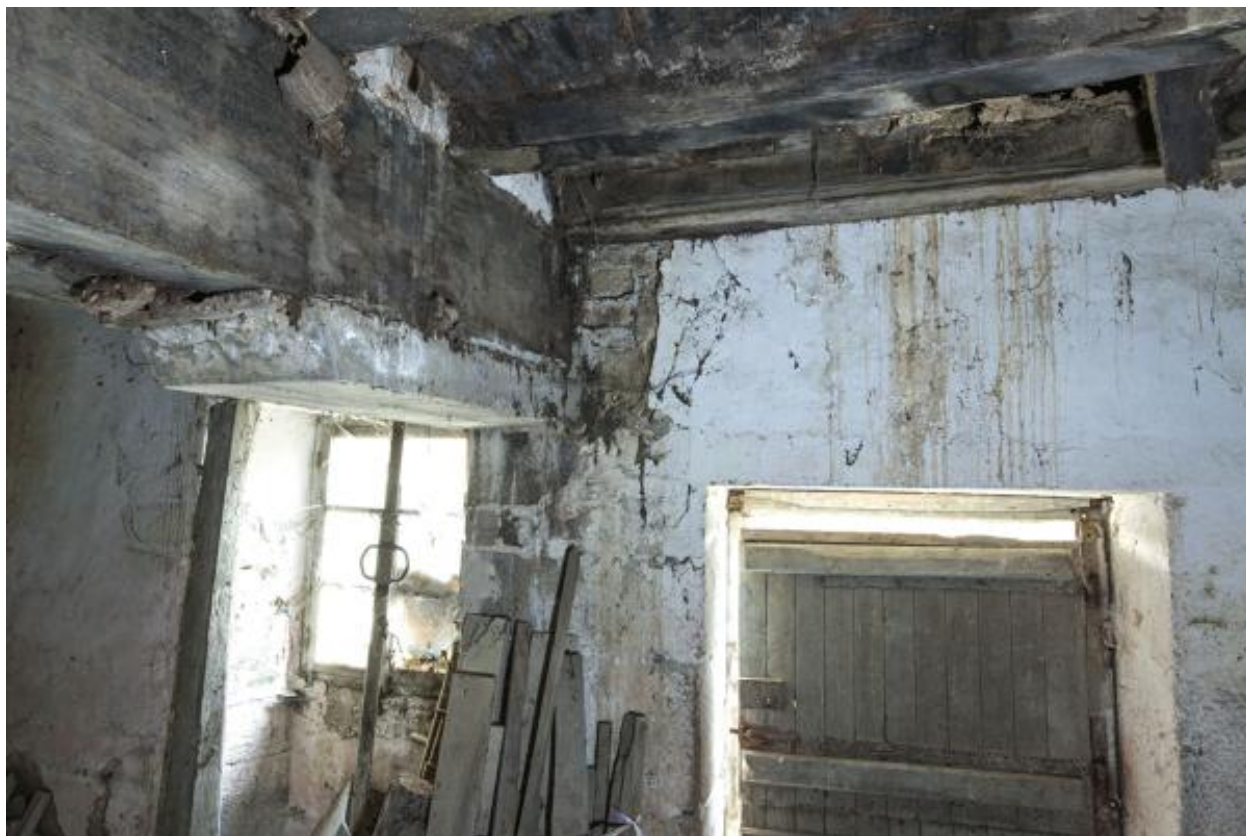
Poutre maîtresse du rez-de-chaussée, pièce nord.
