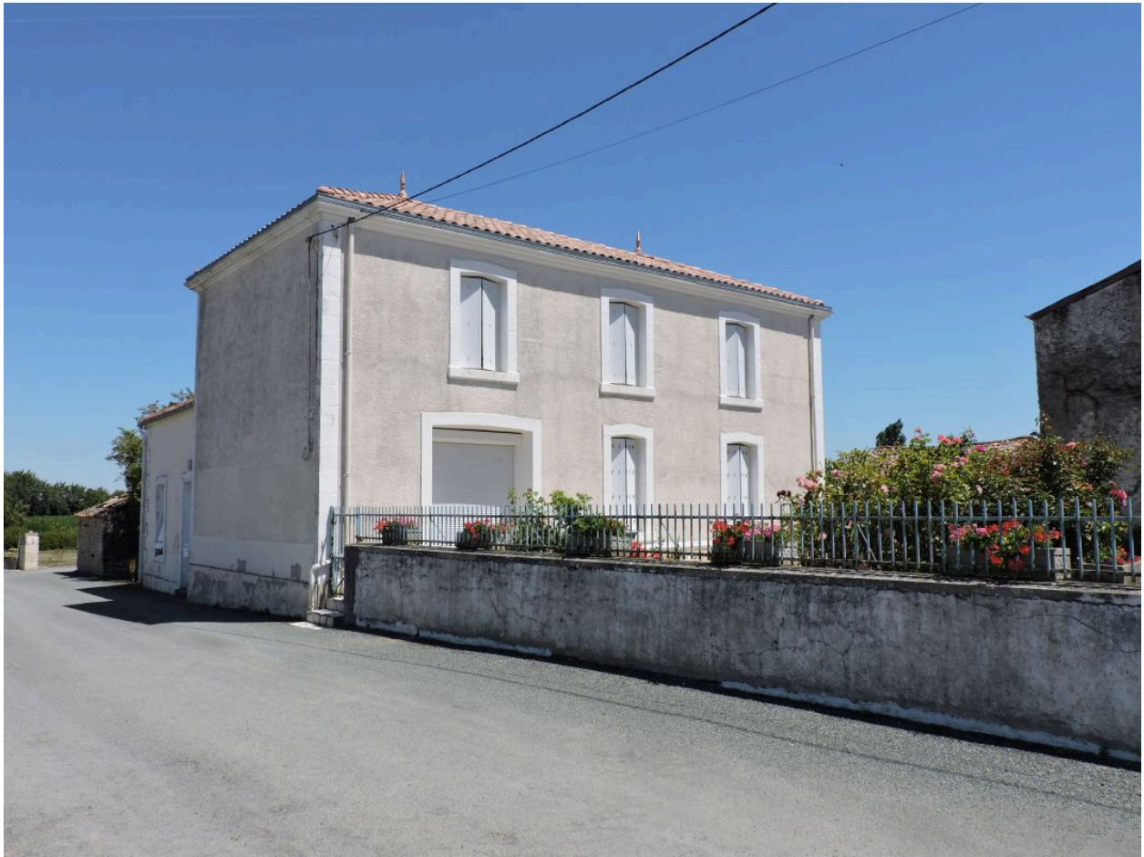
Le logis vu depuis l'ouest.
