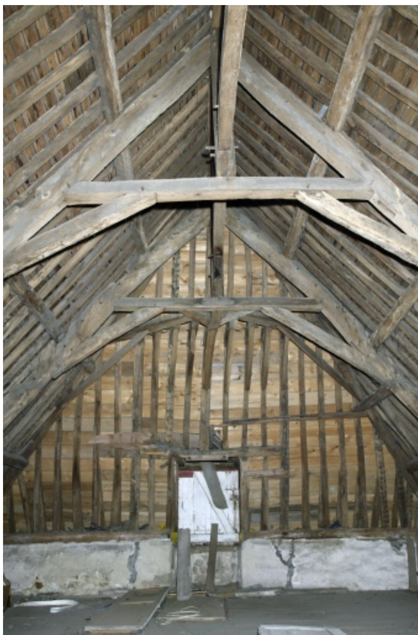
Charpente vue vers l'Ouest.
