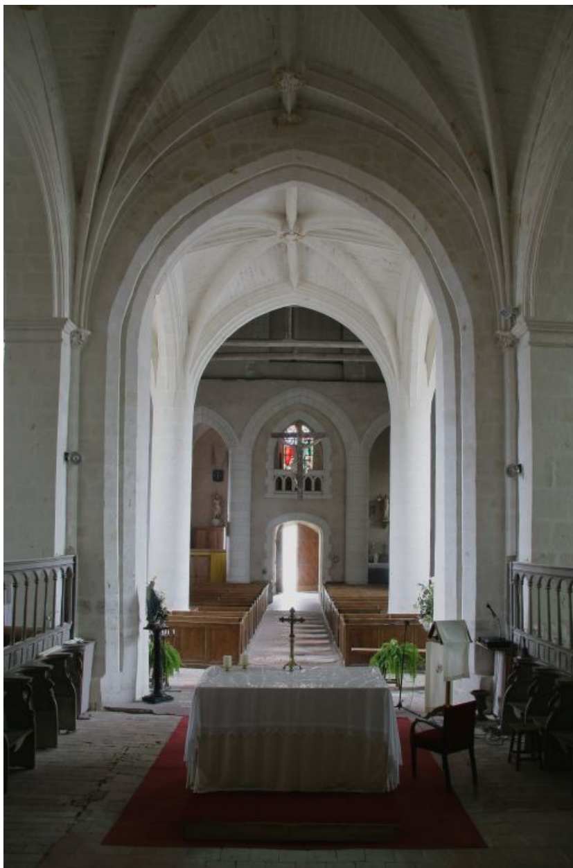
Vue d'ensemble du chœur et de la nef prise du retable.
