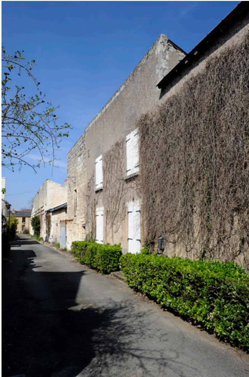
Vue générale des anciens bâtiments de l'Hôpital de la Sainte-Famille.
