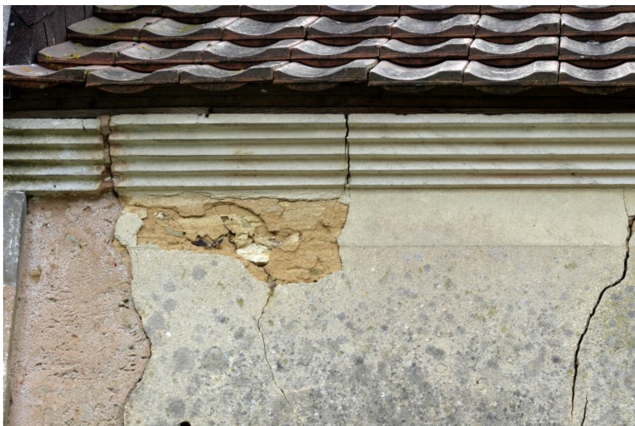
Étables, élévation antérieure : détail de la corniche.
