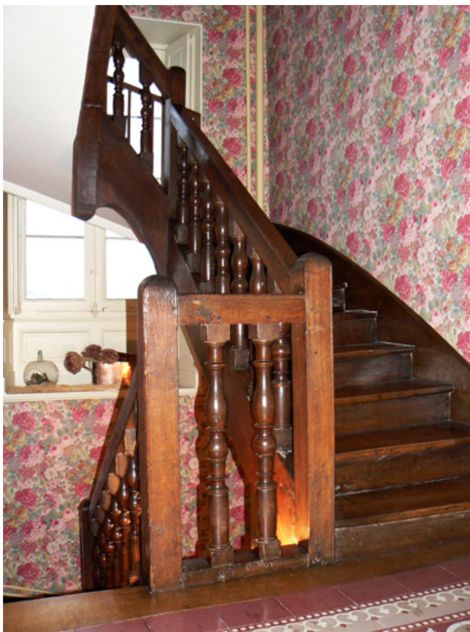
Escalier en bois à balustres.
