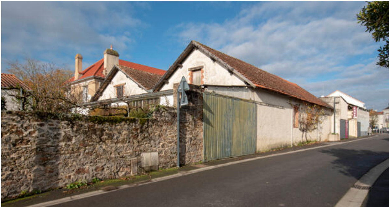
Vue générale des magasin sud.
