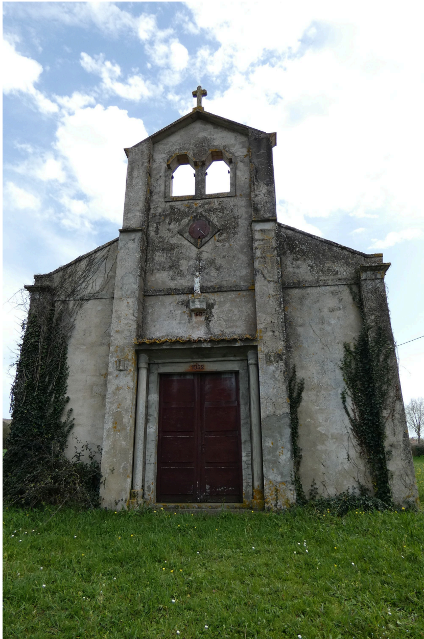
La façade occidentale.
