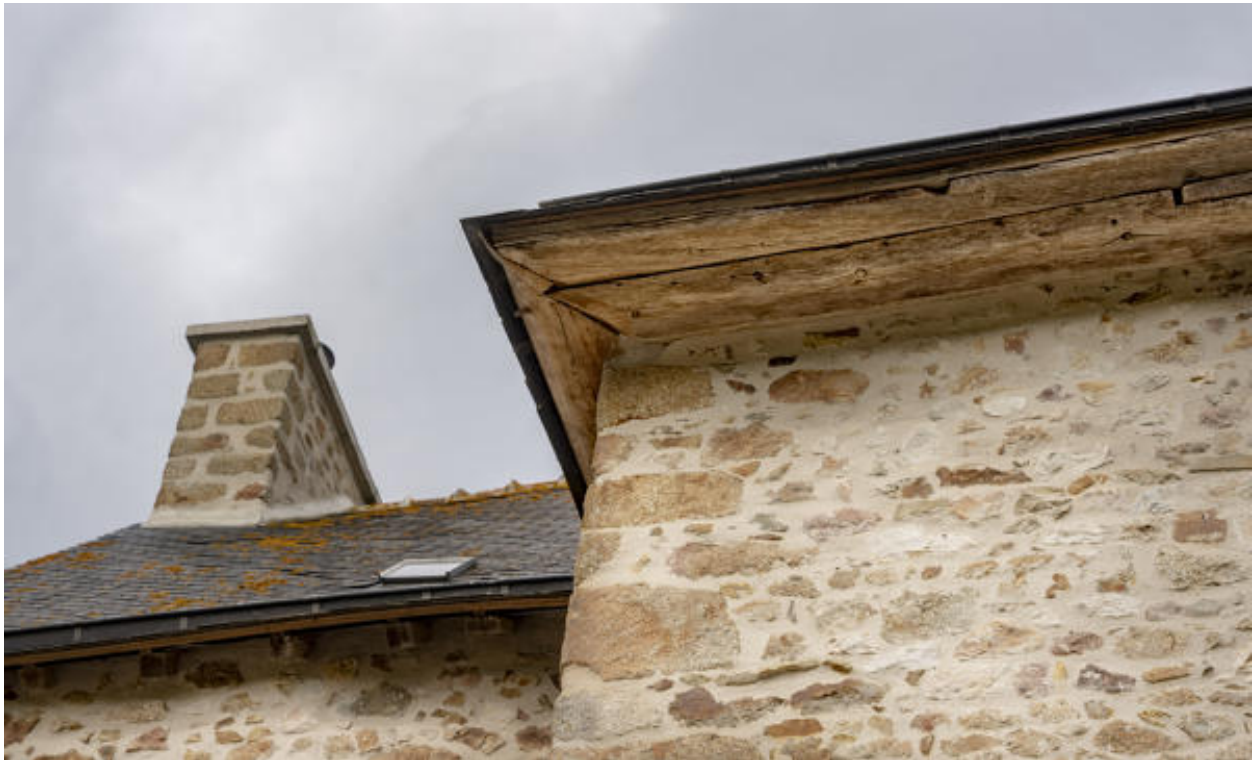
La corniche en bois du pavillon, détail.
