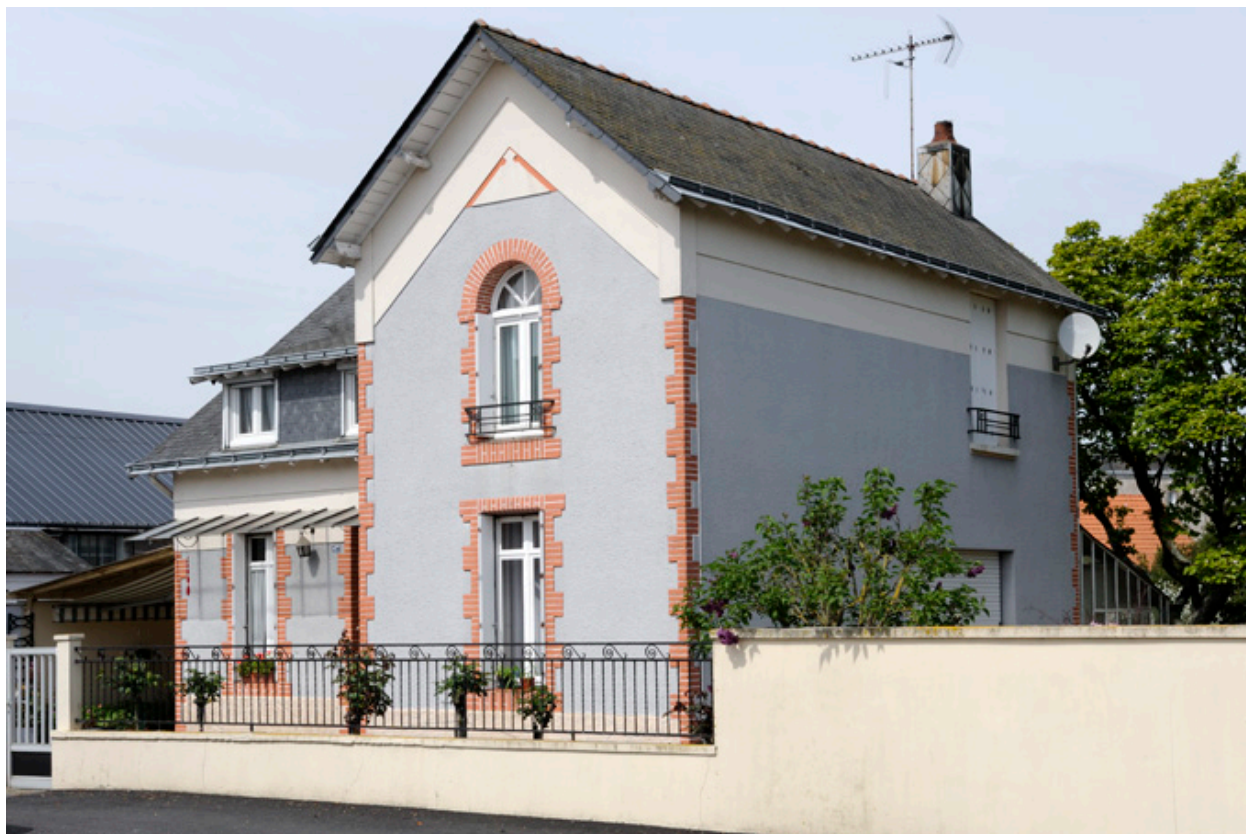
Maison Pierre Corbet, de l'usine de chaussures Corbet-Courbet, située au 47 rue Choletaise.
