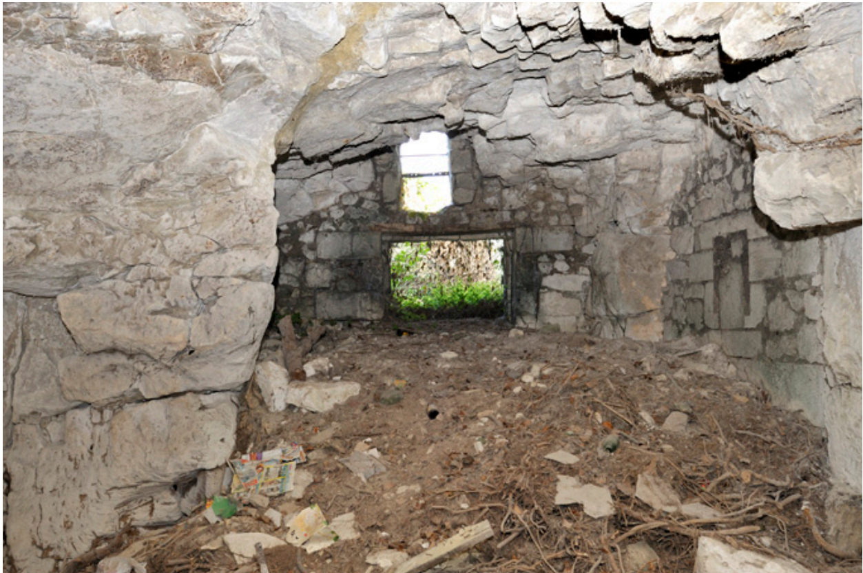
Salle centrale : vue de l'entrée depuis la ruelle Bussy d'Amboise (au nord).
