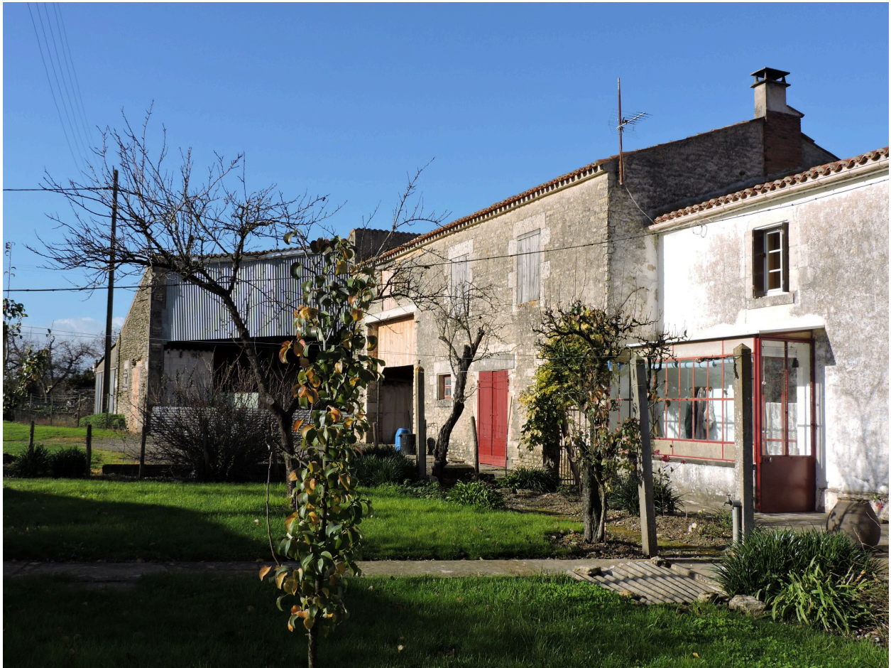
Les dépendances dans le prolongement ouest du logis, vues depuis le sud-est.
