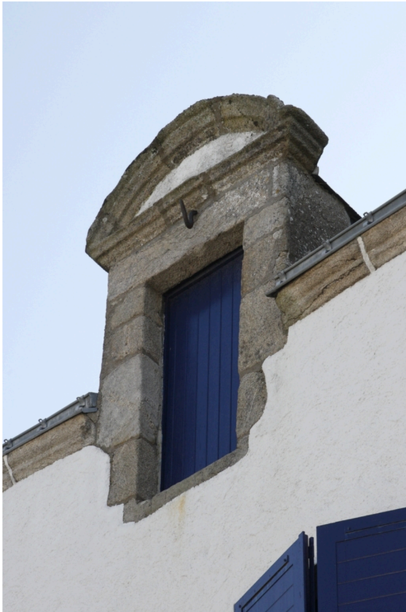
Détail de la lucarne du n° 5 rue du Rocher.
