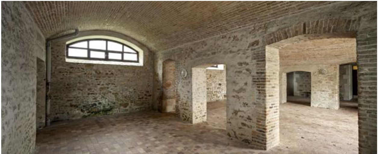
Vue de la structure centrale en rez-de-chaussée depuis le bas-côté est.
