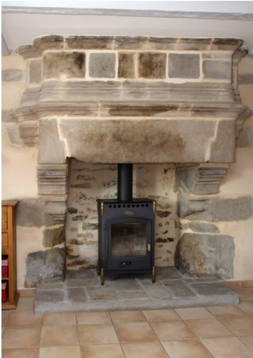
Logis. 1er niveau. Salle ouest. Vue de la cheminée sur le mur pignon ouest.
