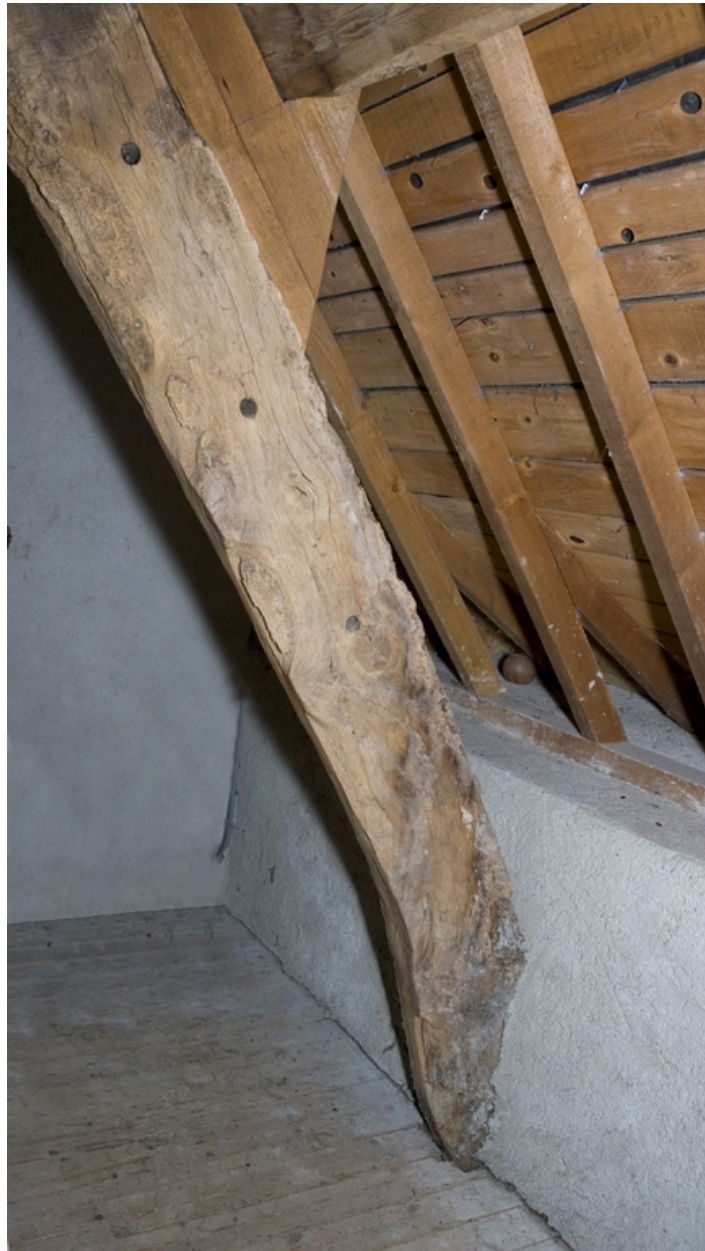
Vieux logis. Charpente. Détail de l'insertion d'un arbalétrier dans la maçonnerie.
