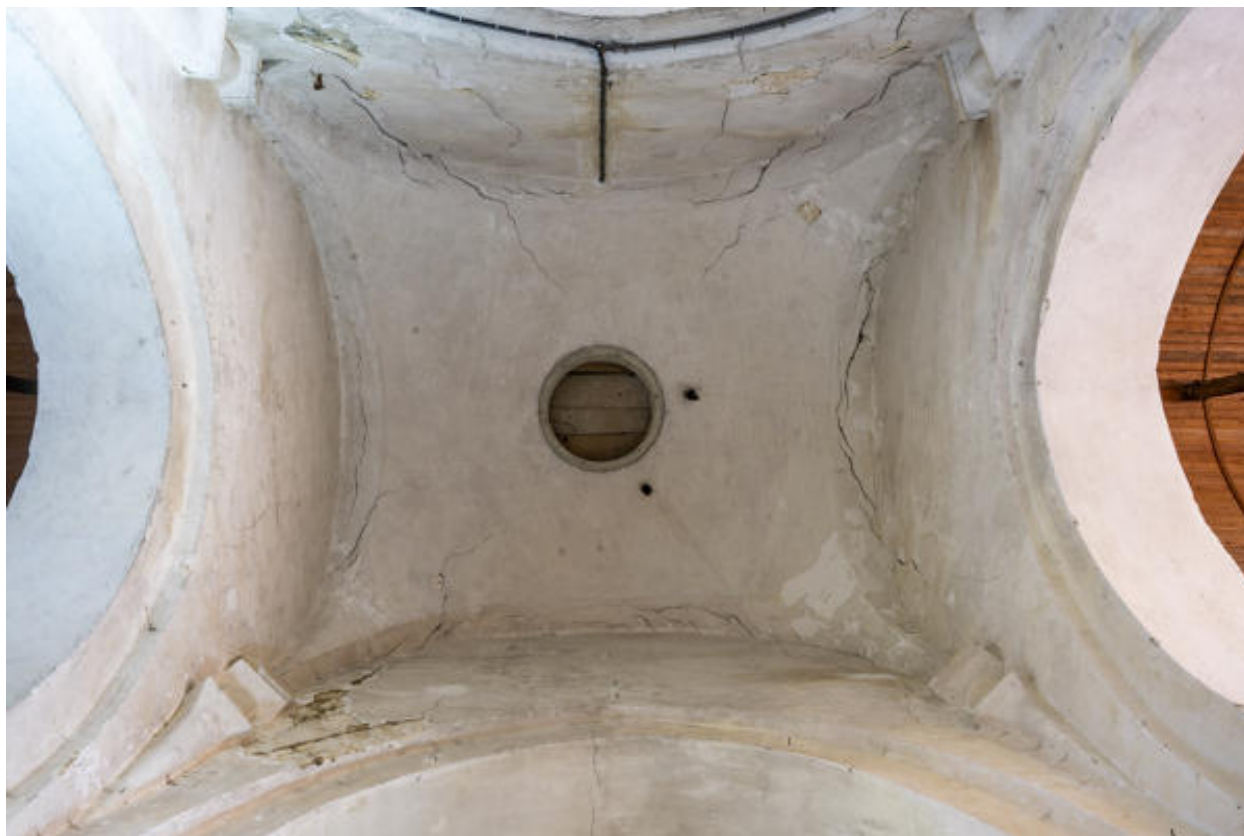
La voûte de la croisée.
