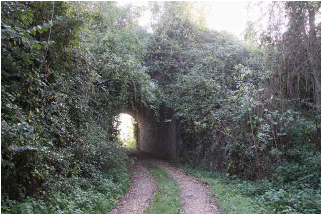
Tunnel sous la voie avant le viaduc : de l'ouest vers l'est.
