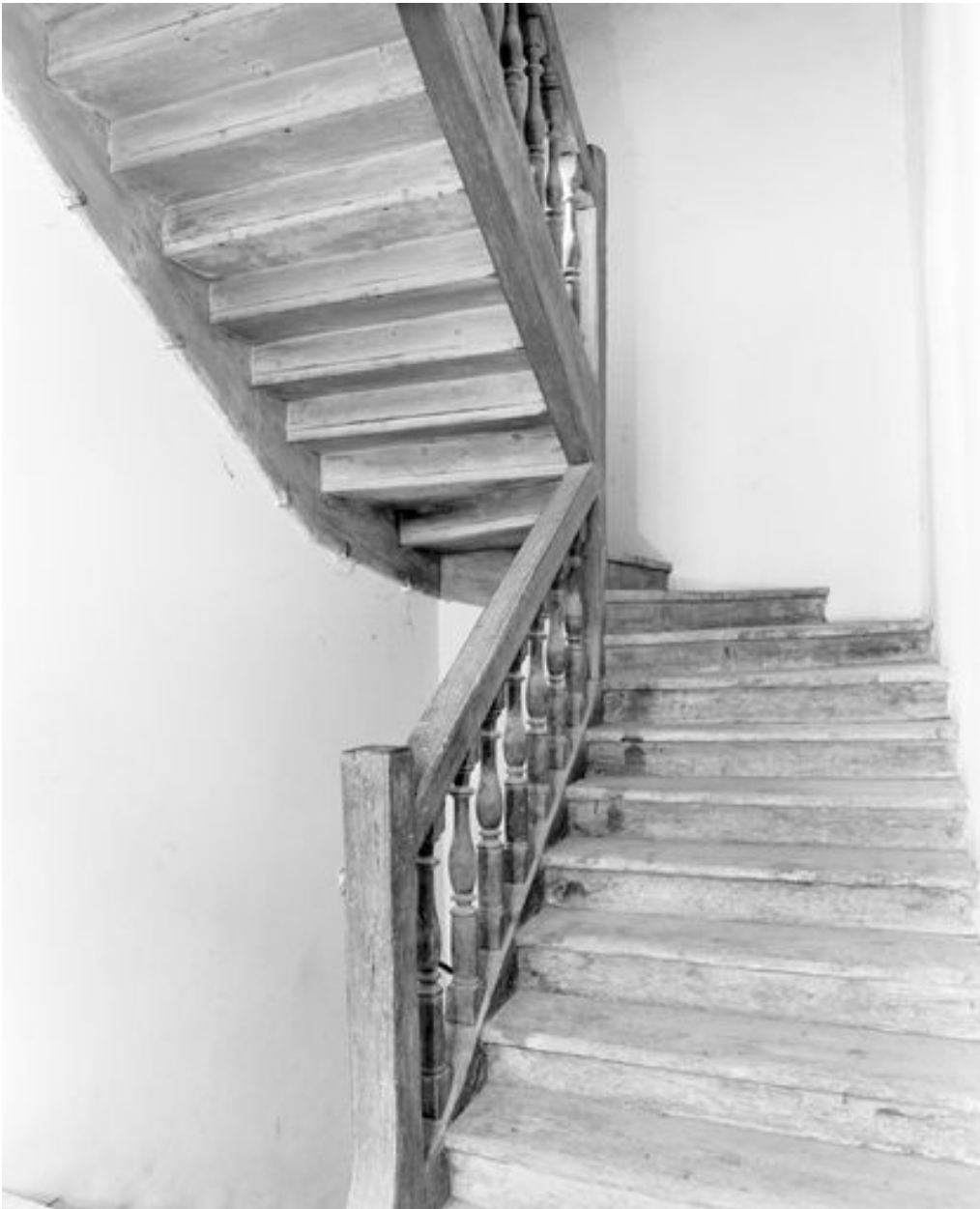
L'escalier situé dans le corps secondaire en retour à l'est (1998).
