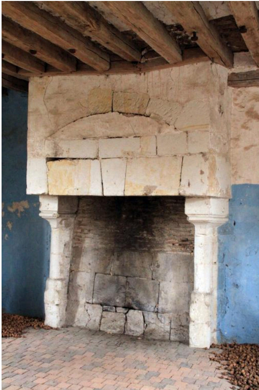
Petite salle du premier étage : cheminée à hotte avec arc de décharge.
