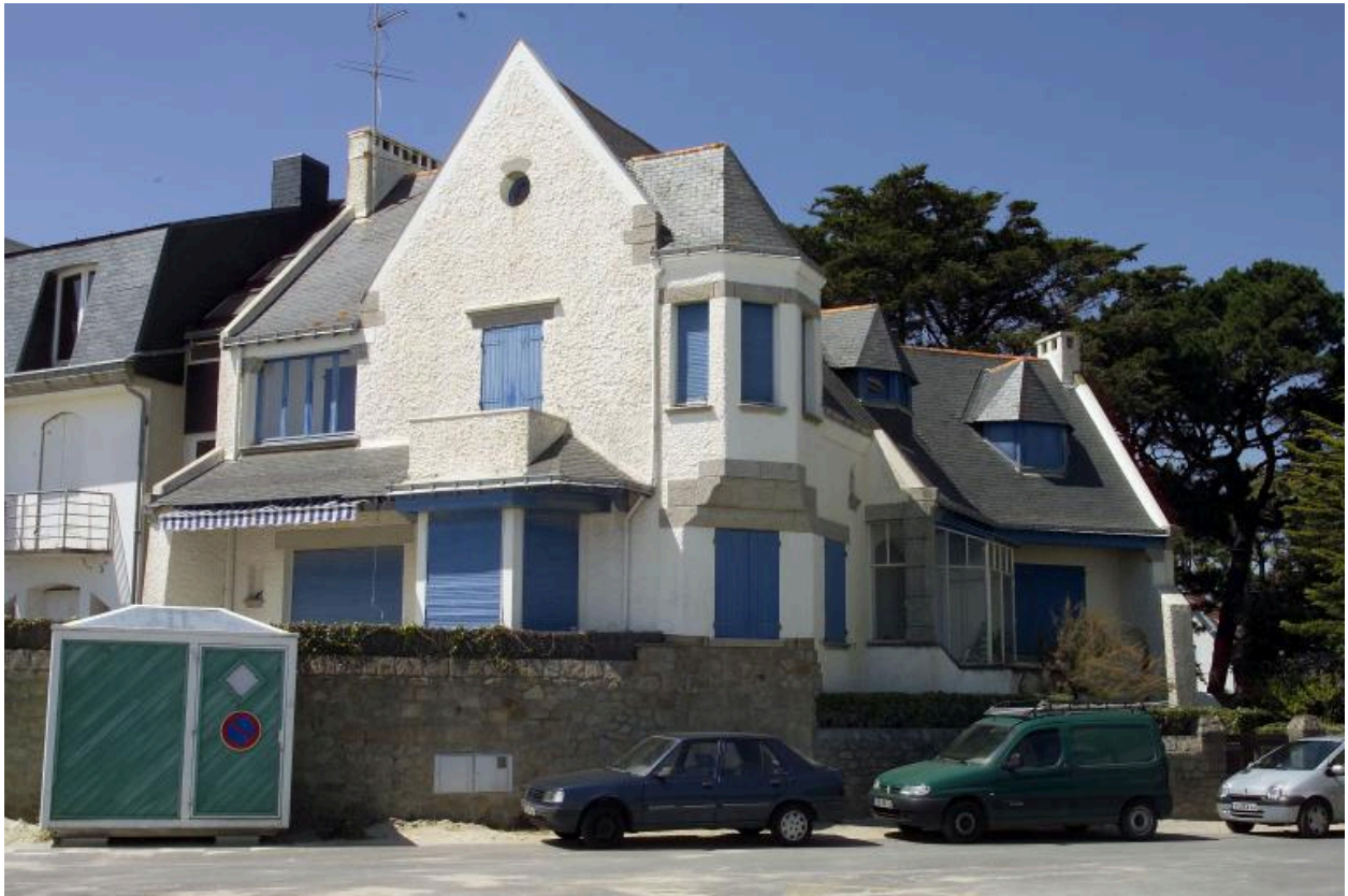
Vue d'ensemble de la villa Saint-Corentin.
