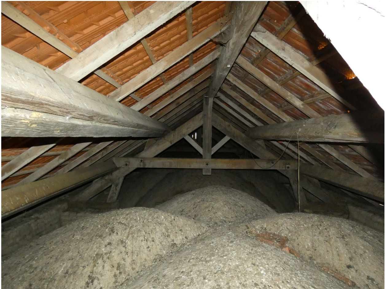
La charpente et les voûtes de la nef.
