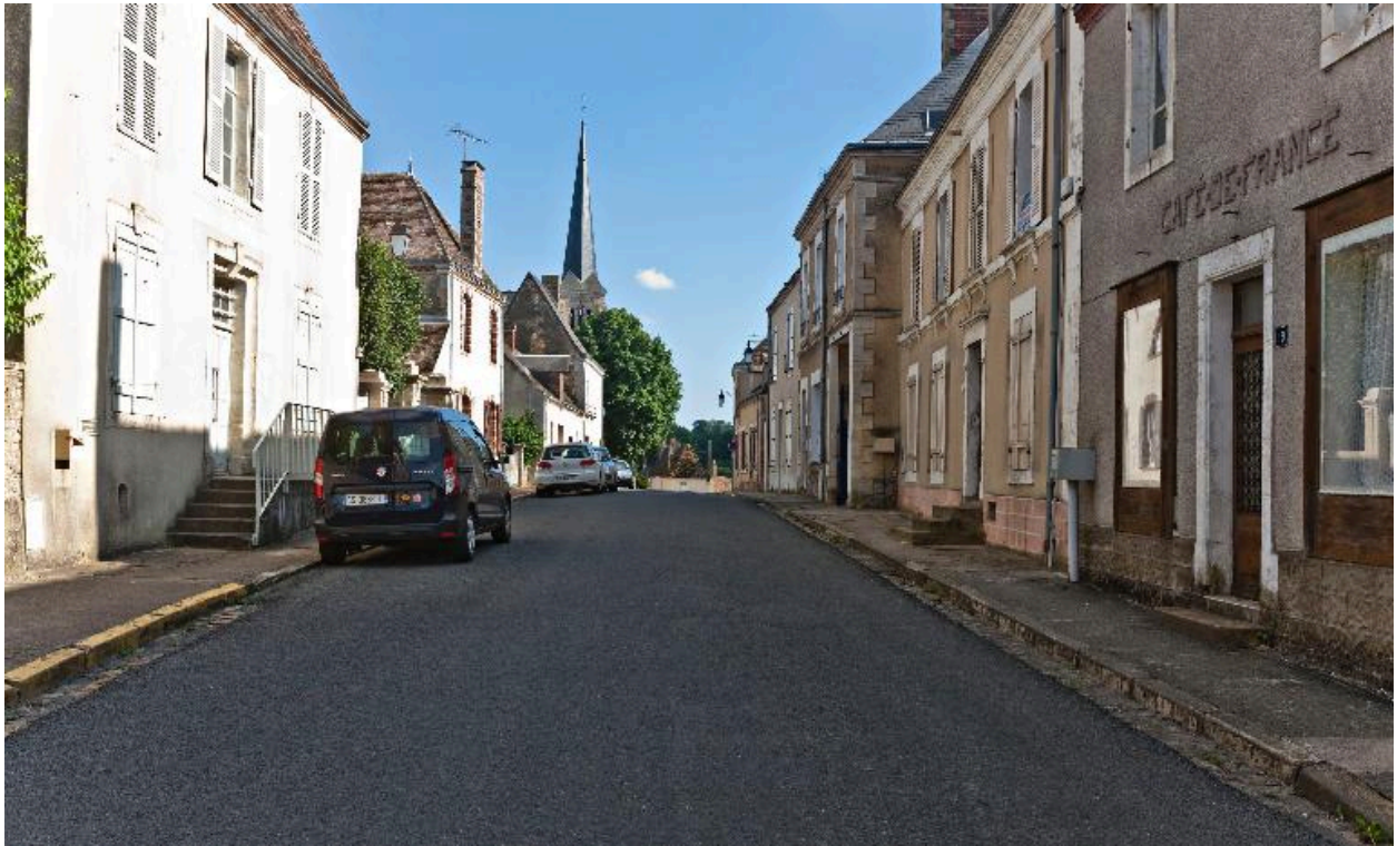
Vue générale depuis la Poste depuis le le nord.
