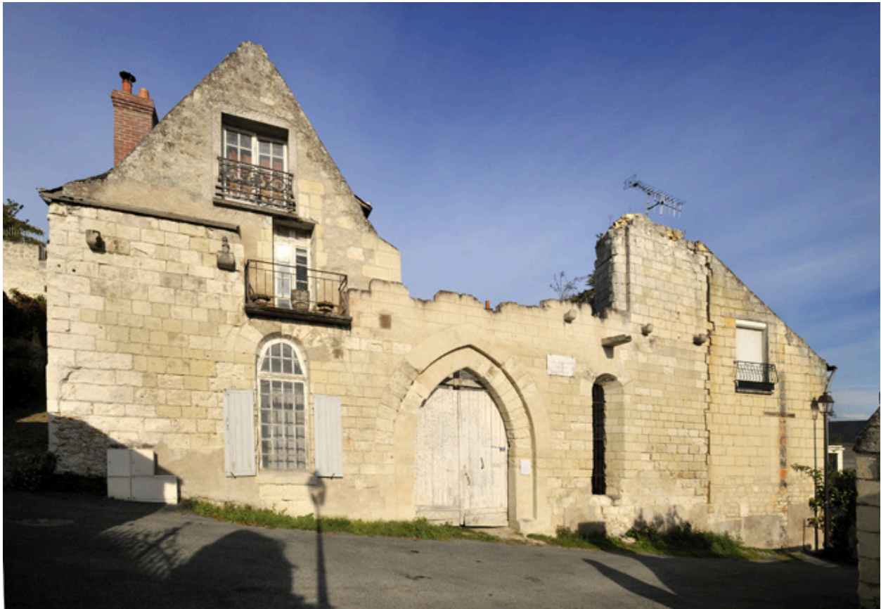
Vue générale : façade principale.
