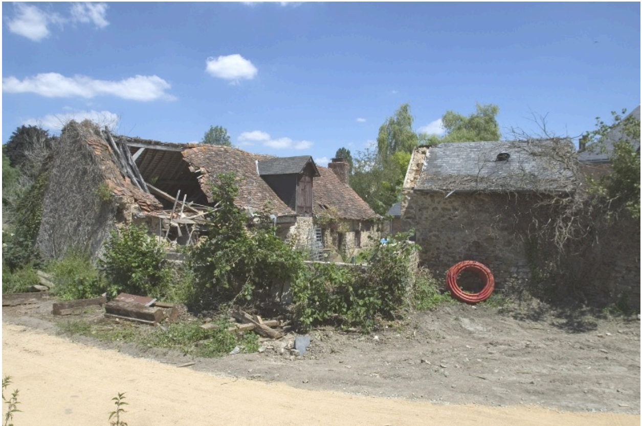
Les logis et la resserre vus depuis l'extérieur de la cour au sud-ouest.
