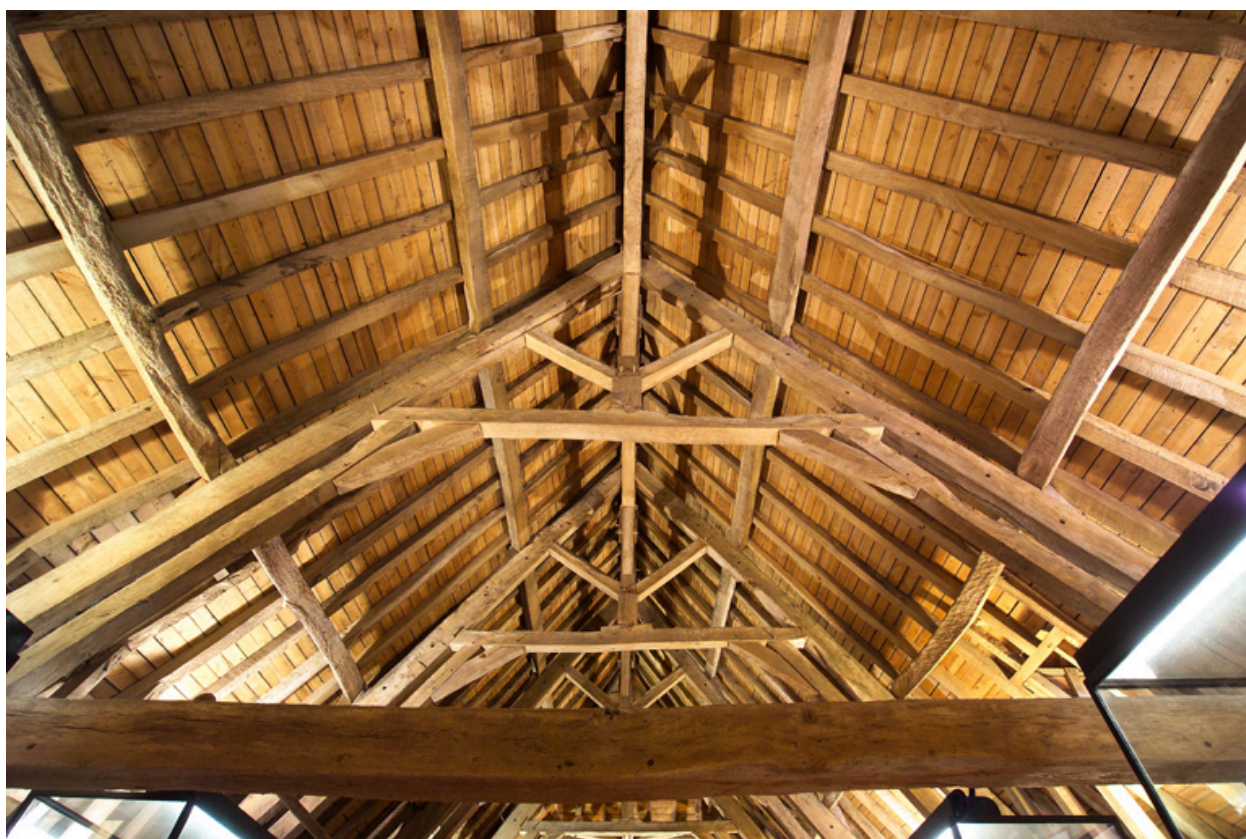
Vue de la charpente.
