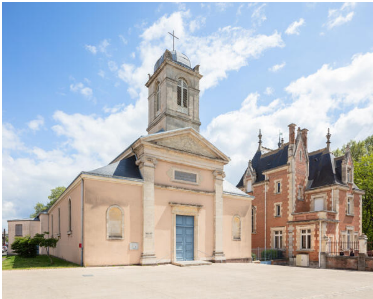
Vue de l'église depuis le nord-ouest.
