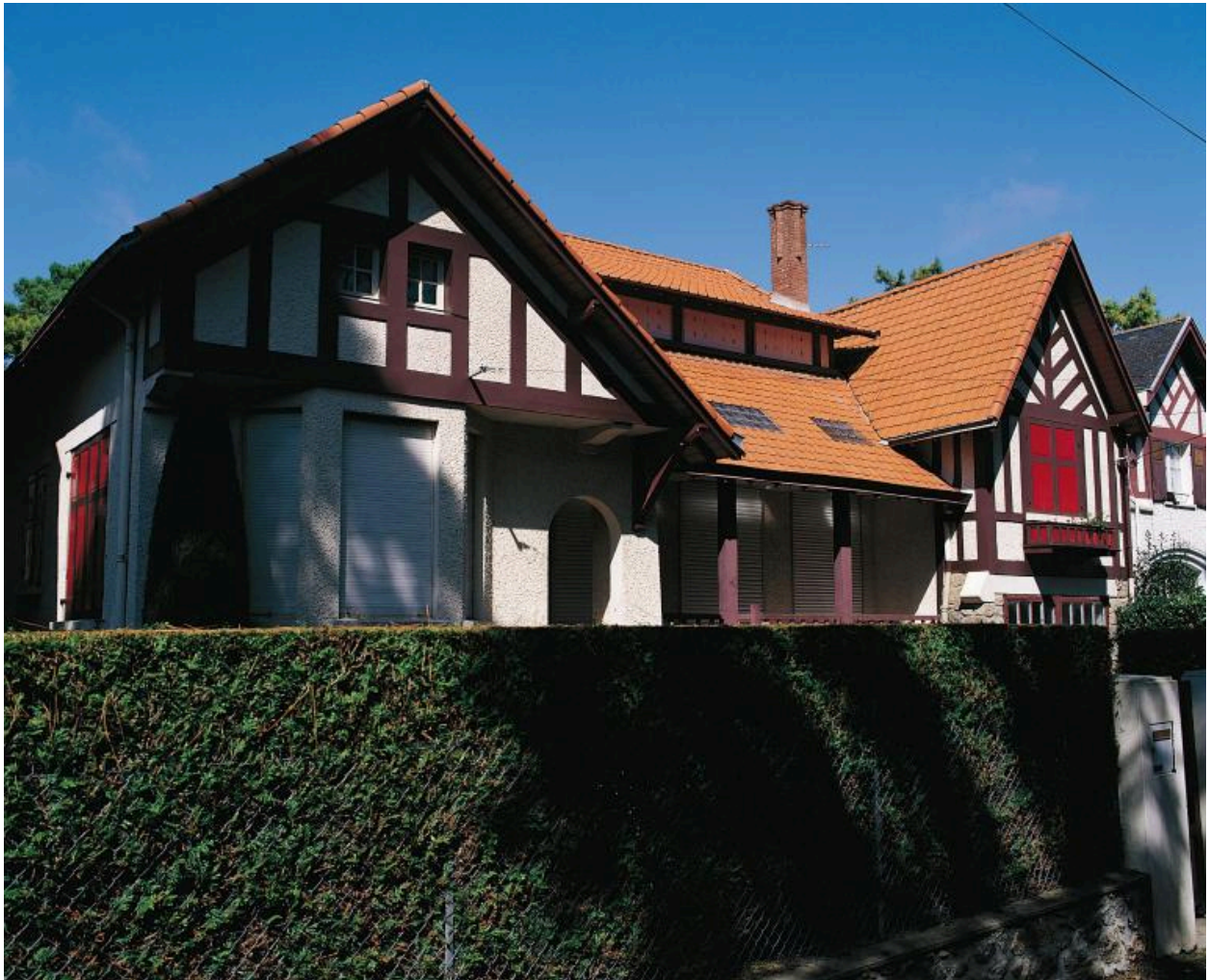
Façade sud-est de la villa Normanni vue du sud.
