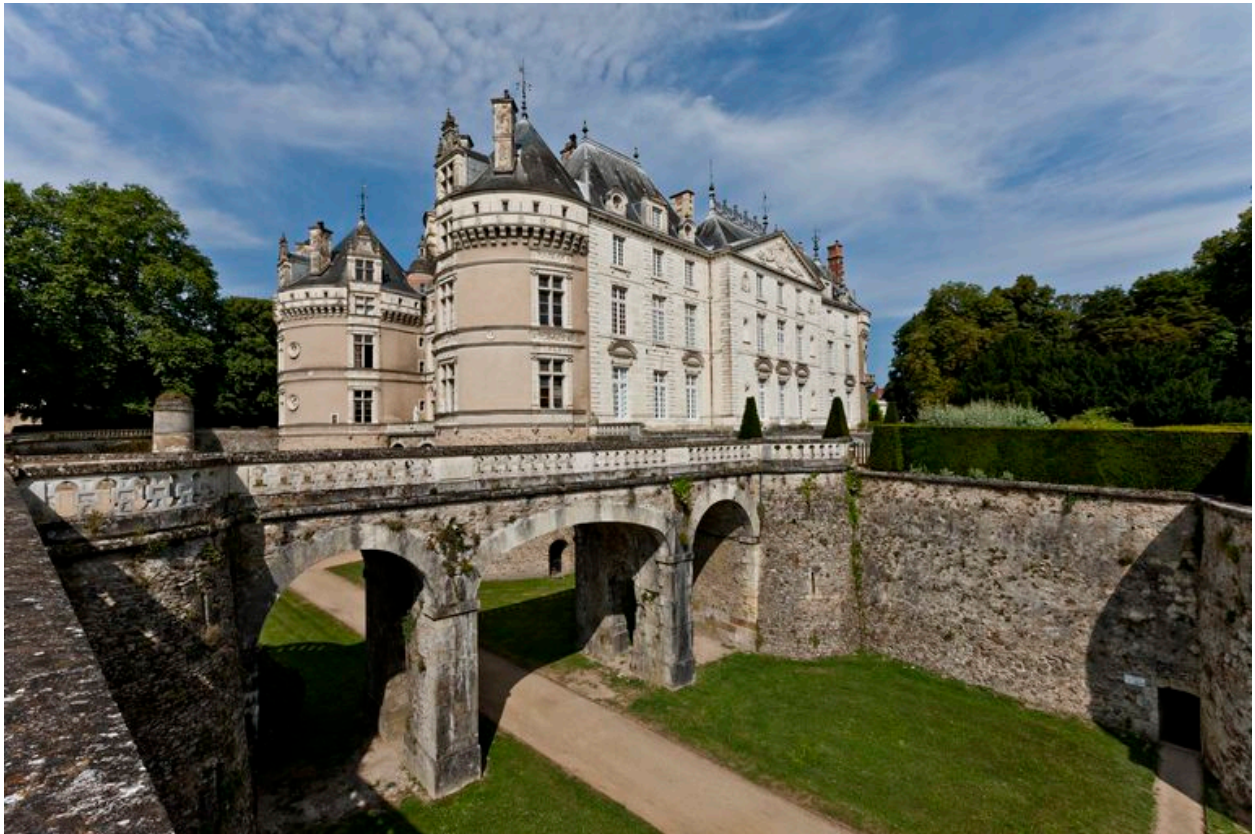
le pont de l'ancienne basse-cour.
