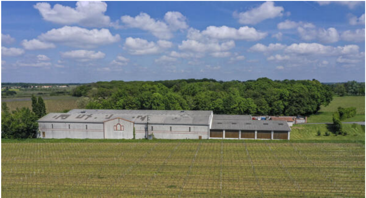
Magasin à vin, vue générale.
